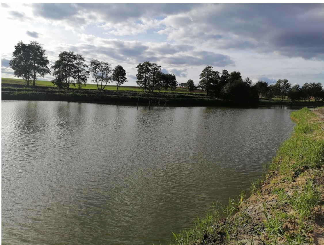
Zdjęcie 3 Zbiornik Egelsee po renowacji
