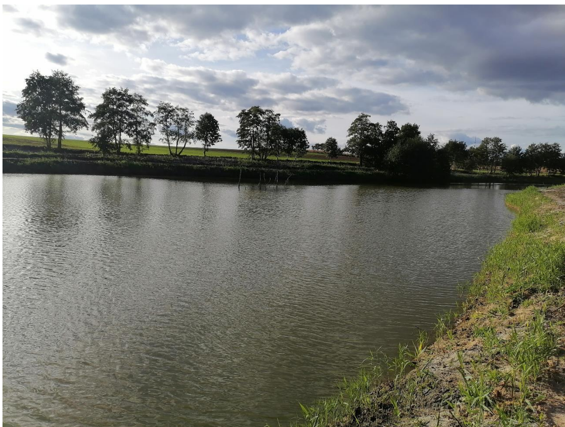
Zdjęcie 3 Zbiornik Egelsee po renowacji
