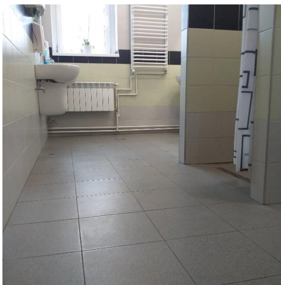
Zdjęcie 9 Remont łazienek - Szkolne Schronisko Młodzieżowe
