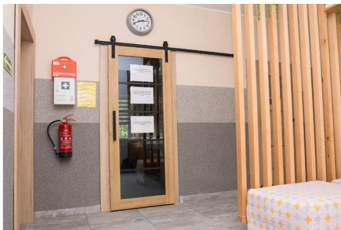
Zdjęcie 11 Remont kuchni i holu - Szkolne Schronisko Młodzieżowe
