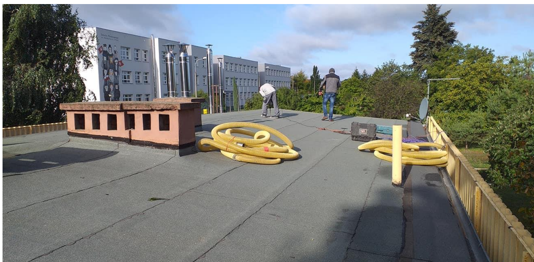
Zdjęcie 11 Docieplenie stropu budynku - Szkolne Schronisko Młodzieżowe
