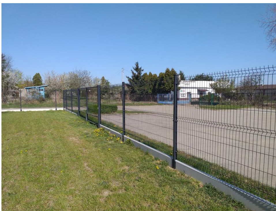
Zdjęcie 12 Ogrodzenie Schroniska młodzieżowego w Śmiglu
