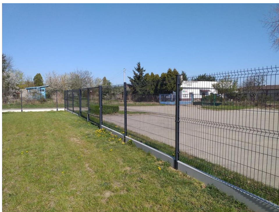
Zdjęcie 12 Ogrodzenie Schroniska młodzieżowego w Śmiglu
