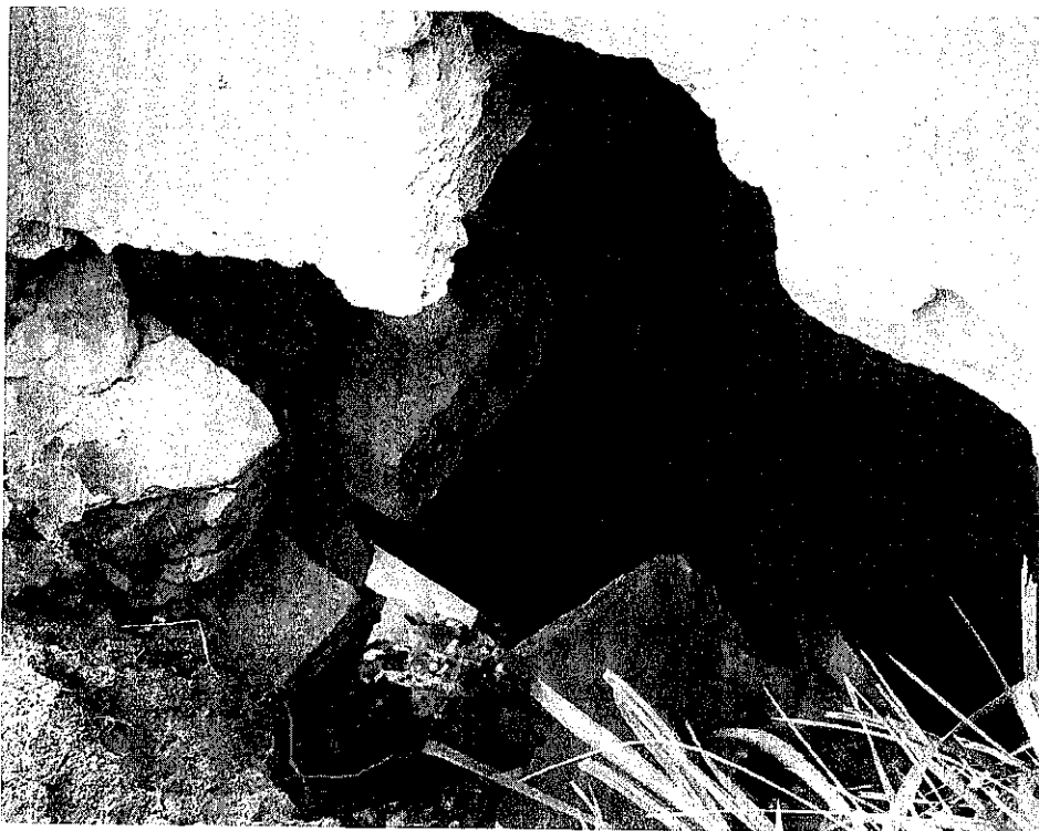
fot.23. Mur zachodni – część południowa, fragment w widoku od strony cmentarza - część muru która uległa awarii. Mur jest zniszczony na całej szerokości, dołem widoczny prześwit na zewnątrz, wyżej otwór osłania drewniana płyta prowizorycznego zabezpieczenia (fot. 19).
