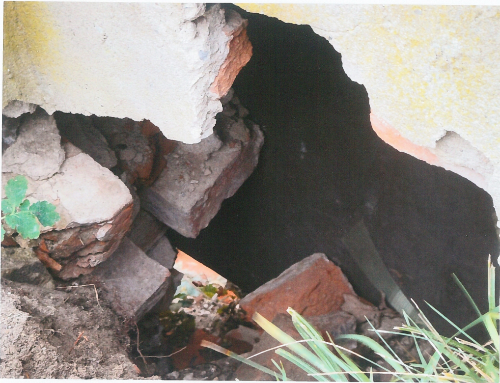
fot.23. Mur zachodni – część południowa, fragment w widoku od strony cmentarza - część muru która uległa awarii. Mur jest zniszczony na całej szerokości, dołem widoczny prześwit na zewnątrz, wyżej otwór osłania drewniana płyta prowizorycznego zabezpieczenia (fot.19).
