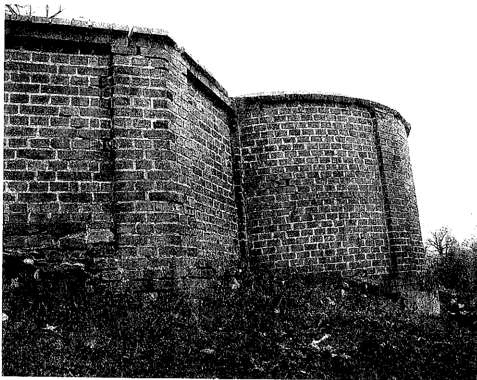
fot.32. Naroże muru zachodniego (po prawej) i północnego (po lewej), w widoku od strony ulicy. Po prawej stronie taras widokowy, wykorzystywany w trakcie zgromadzeń religijnych do wygłaszania kazań. Widoczne pionowe i ukośne pęknięcia muru przy pilastrze narożnym. Dołem w murach, również tarasu widokowego, część cegieł jest zniszczonych oraz występują głębokie ubytki zaprawy.
