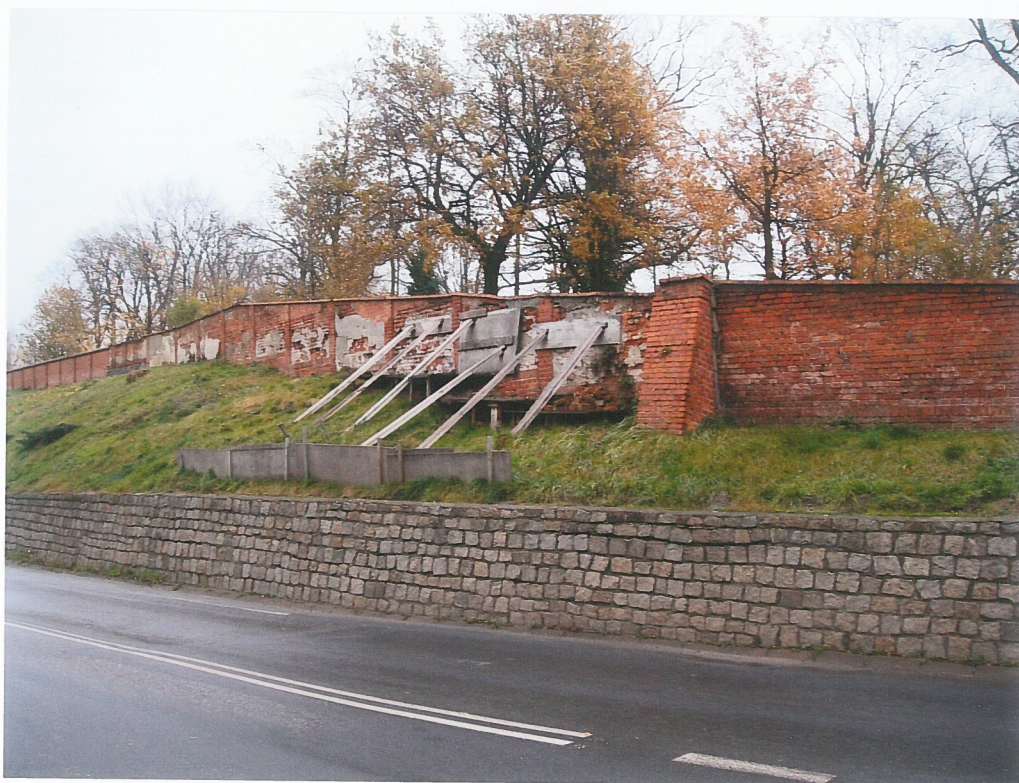
fot.17. Mur zachodni – część południowa, w widoku od strony ulicy - część muru która uległa awarii. Widoczne współczesne prowizoryczne zabezpieczenie tej partii muru, aby nie osunęła się na skarpę i na jezdnię ulicy.
