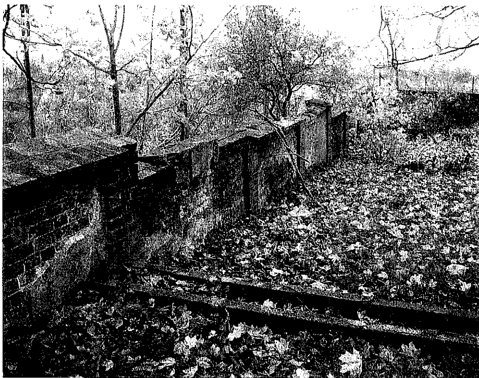
fol.8. Mur północny – część środkowa, w widoku od strony cmentarza. Widoczne rozległe ubytki tynku oraz częściowo ubytki cegieł na koronie muru.
