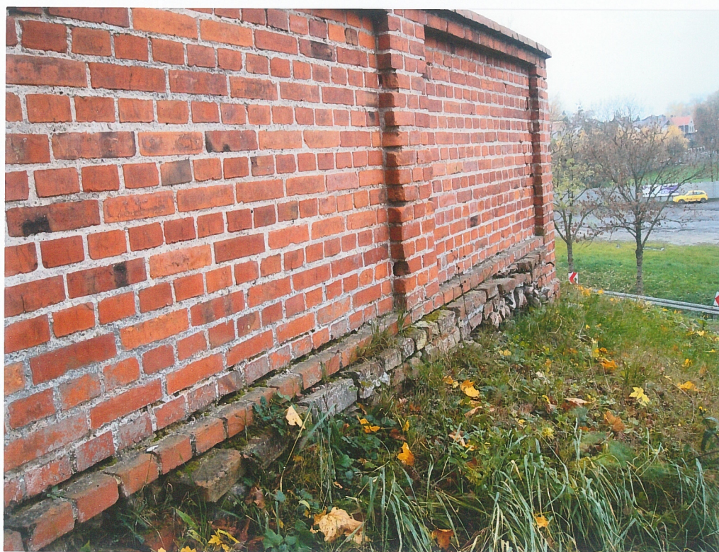
fot.36. Mur północny - fragment zachodni, w widoku od strony ulicy. Stan muru jest ogólnie zadowalający, z wyjątkiem dolnych partii, gdzie część cegieł jest zniszczonych oraz występują głębokie ubytki zaprawy.
