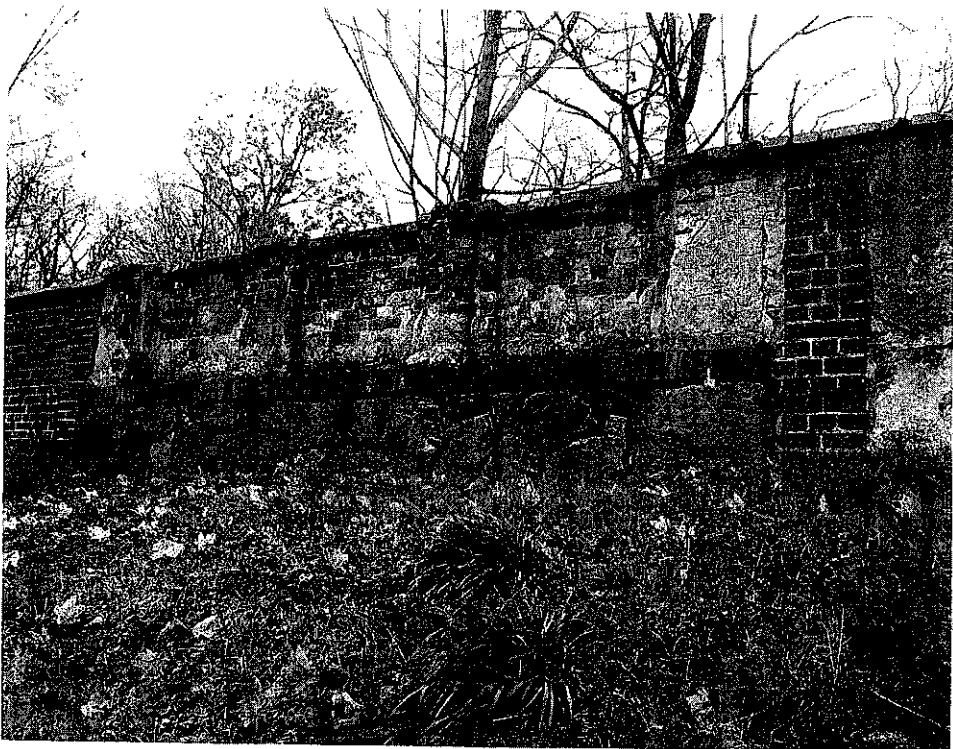
fot.26. Mur zachodni – część środkowa, w widoku od strony ulicy. Część muru z pilastrami, górą mur ceglany, dołem z kamieni o znacznych rozmiarach. W murze ceglany rozległe ubytki tynku, część cegieł jest skorodowanych z ubytkami oraz głębokie ubytki zaprawy. W murze kamiennym głębokie ubytki zaprawy – kamienie nie związane zaprawą.
