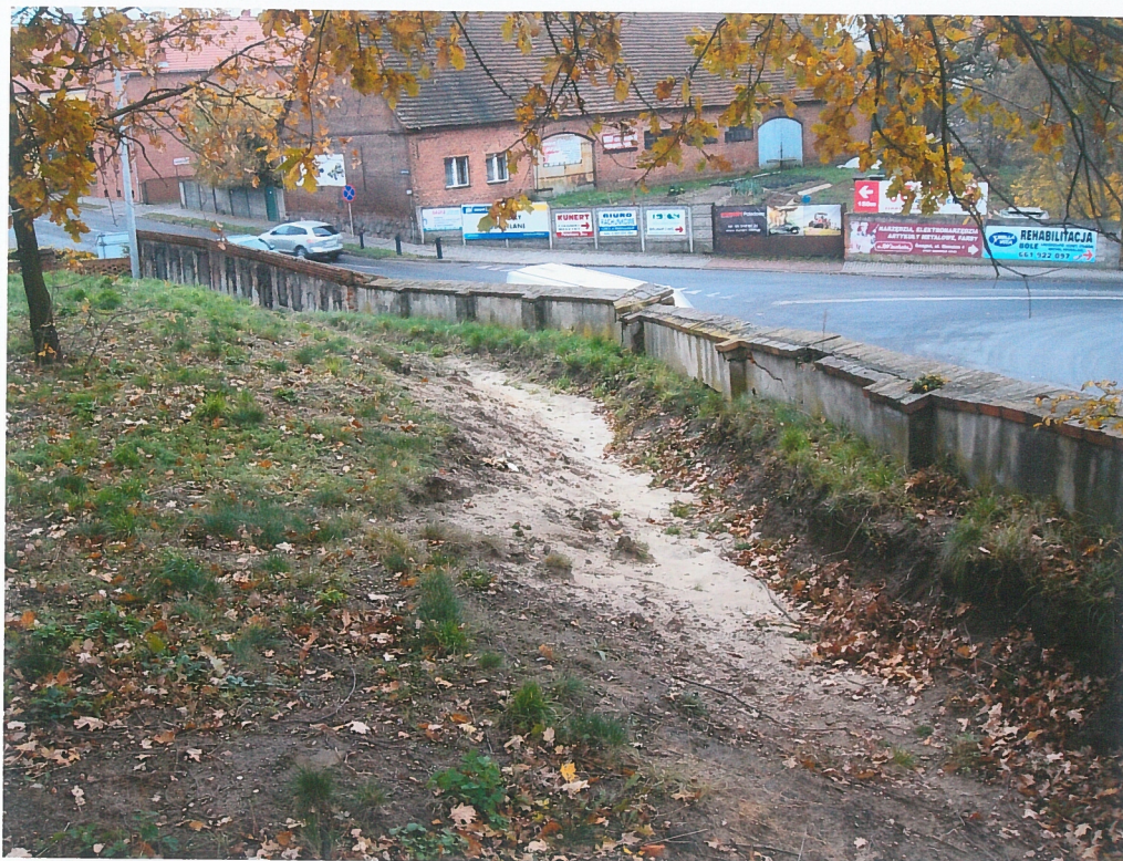
fot.5. Mur zachodni – część południowa w widoku od strony cmentarza. Wzdłuż muru widoczna wykopana w ziemi rynna mająca zmniejszyć napór gruntu na mur oraz odprowadzić wodę powierzchniową, aby nie spływała z cmentarza na mur i nie powodowała jego zawilgocenia.
