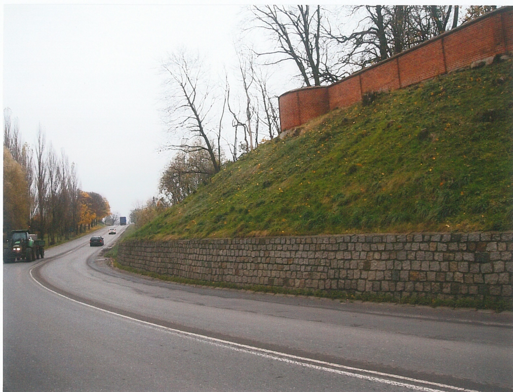
fot.41. Skarpa zachodnia w części północnej. Górą ceglany mur cmentarny, dołem skarpy współczesny kamienny mur oporowy, o wysokości dochodzącej do 1,50 m. Skarpa jest wysoka, stroma o pochyleniu ponad 30°. Skarpa jest porośnięta trawą.
