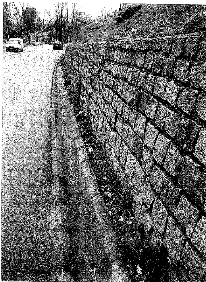
fot.44. Mur oporowy - w części środkowej. Mur został wykonany wspólnie z kostki kamiennej granitowej, o wymiarach około 20/20, 30/20 cm, na mocnej zaprawie cementowej. Między murem oporowym, a jezdnią ulicy jest koryto z elementów betonowych odprowadzające wodę opadową.
