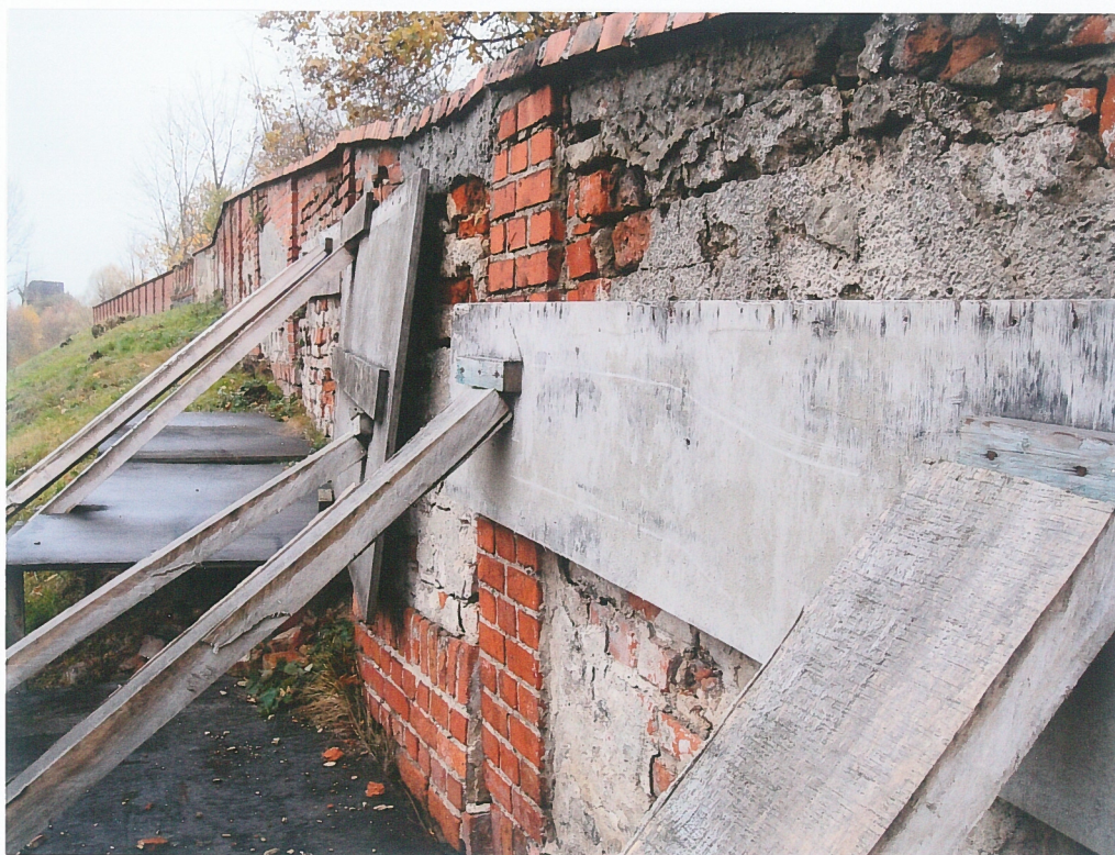
fot.20. Mur zachodni – część południowa, w widoku od strony ulicy - część muru która uległa awarii. Widoczne podparcie płyt drewnianych zastrzałami opartymi na elementach drewnianych mocowanych do płyt 2 gwoździami każdy.
