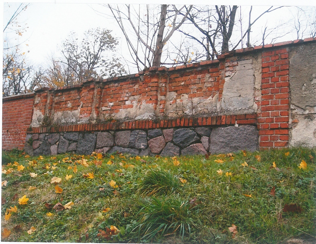
fot.26. Mur zachodni – część środkowa, w widoku od strony ulicy. Część muru z pilastrami, górą mur ceglany, dołem z kamieni o znacznych rozmiarach. W murze ceglanym rozległe ubytki tynku, część cegieł jest skorodowanych z ubytkami oraz głębokie ubytki zaprawy. W murze kamiennym głębokie ubytki zaprawy – kamienie nie związane zaprawą.
