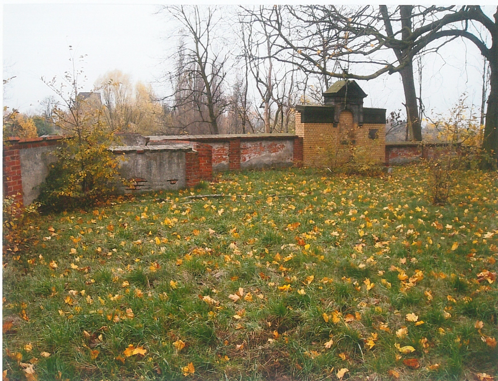
fot.31. Naroże muru zachodniego (po lewej) i północnego (po prawej), w widoku od strony cmentarza. Po lewej stronie taras widokowy. W murach rozległe ubytki tynku.
