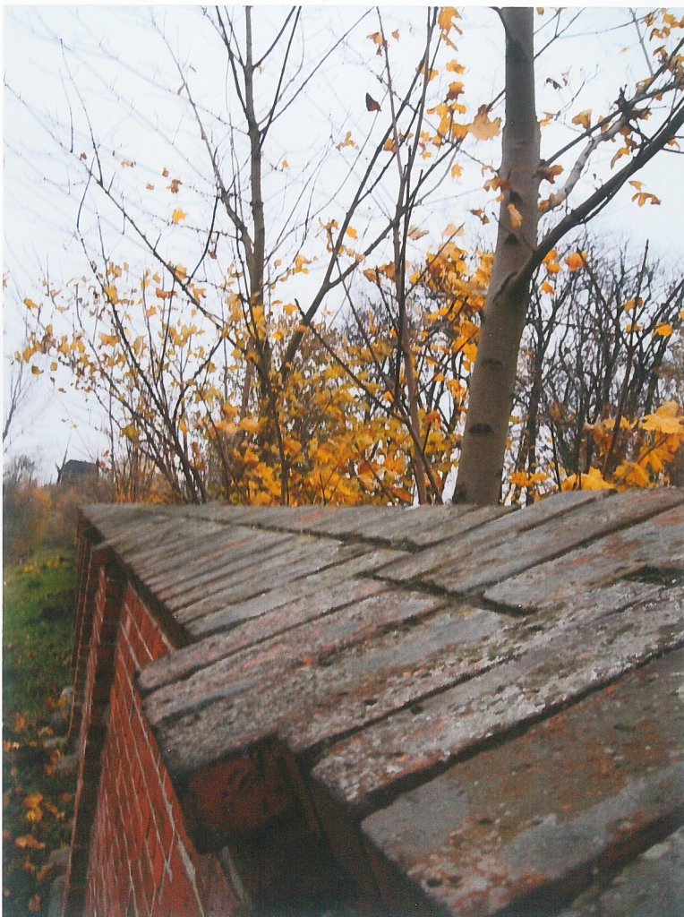
fot.30. Mur zachodni – część północna. Korona muru jest z cegieł ułożonych w spadku w kierunku ulicy. Na koronie liczne ubytki zaprawy.
