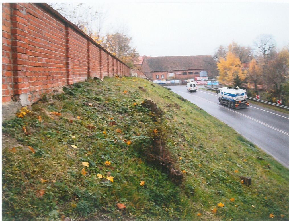
fot.27. Mur zachodni – część środkowa i północna, w widoku od strony ulicy. Mur jest bez zniszczeń. W części fundamentowej muru cegły miejscami zniszczone.
