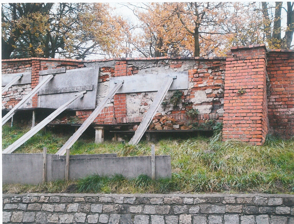
fot.19. Mur zachodni – część południowa, w widoku od strony ulicy - część muru która uległa awarii. Widoczna ściana o licznych zniszczonych i częściowo niezwiązanych zaprawą ceglach. W ścianie widoczne ukośne pęknięcia oraz rozliczne ubytki cegieł. Po lewej stronie widoczne pionowe przemieszczenie ściany. Ścianę zabezpieczono płytami drewnianymi podpartymi zastrzałami drewnianymi. Dołem pomosty drewniane na których leżą spadające cegły.
