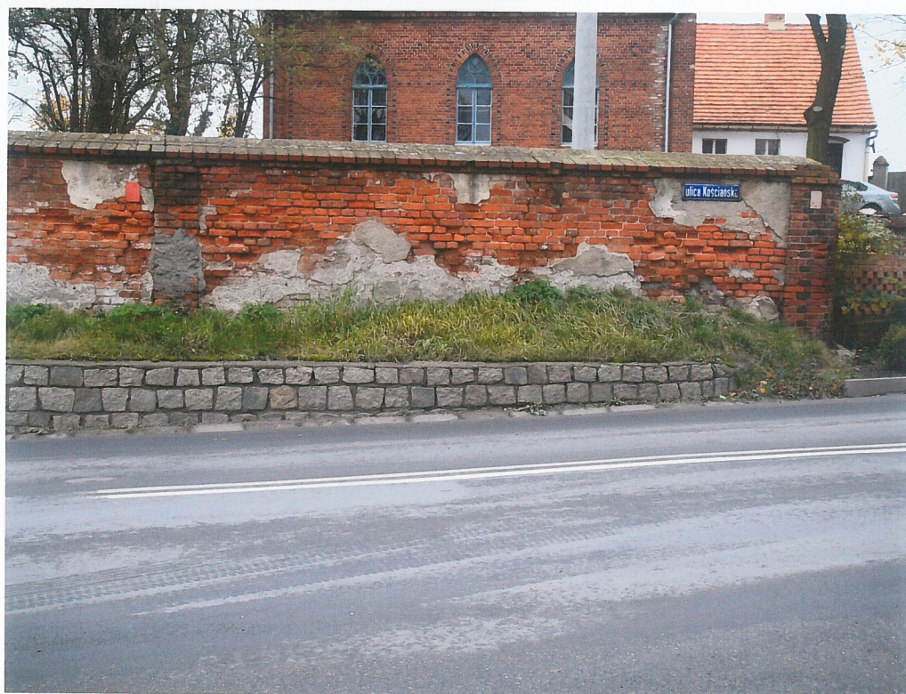
fot.14. Mur zachodni – część południowa (mur w którym od strony cmentarza są wmurowane płyty nagrobne), w widoku od strony ulicy. Widoczne rozległe ubytki tynku oraz liczne głęboko skorodowane cegły z głębokimi ubytkami. Korona muru jest bez zniszczeń.
