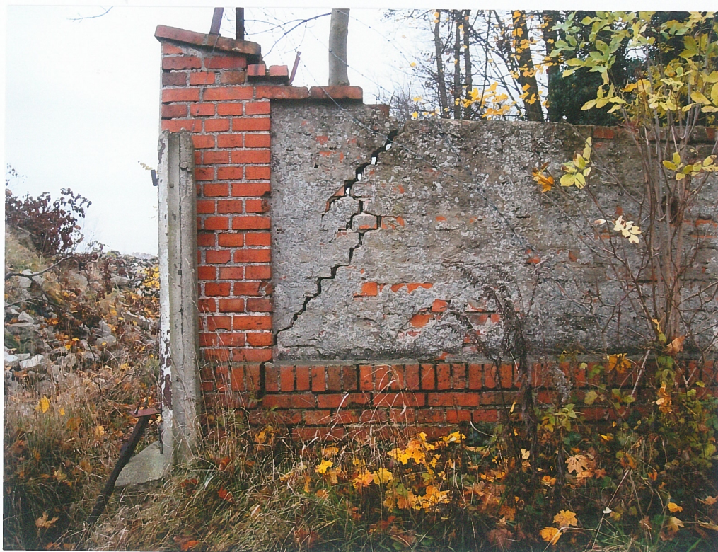
fot.38. Mur północny – fragment części wschodniej, w widoku od strony skarpy północnej. Widoczne ukośne pęknięcie muru, o znacznej rozwarości, rozwierające się ku górze. Charakter pęknięcia wskazuje, że przyczyną jest tu odchylanie się muru wschodniego.
