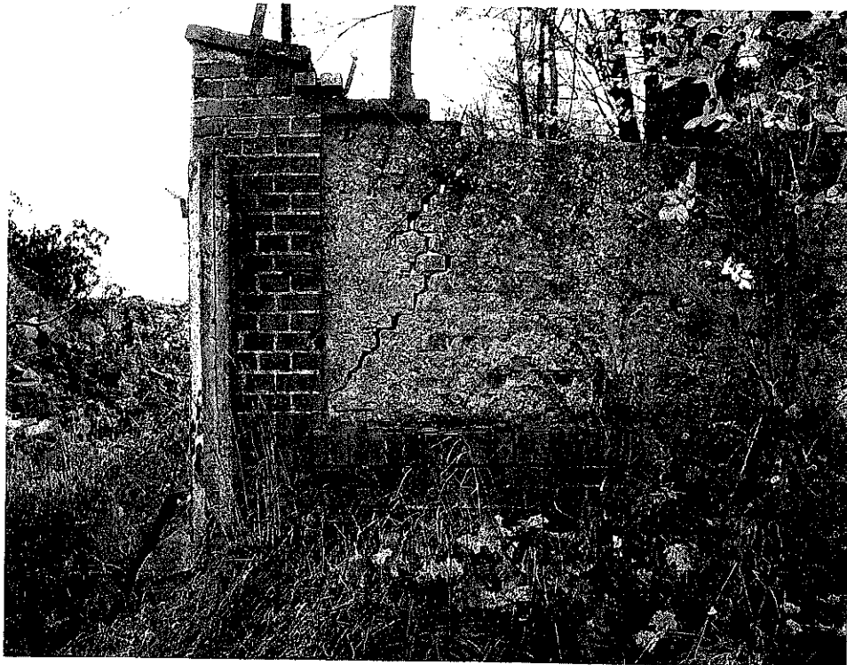
fot.38. Mur północny – fragment części wschodniej, w widoku od strony skarpy północnej. Widoczne ukośne pęknięcie muru, o znacznej rozwartości, rozwierające się ku górze. Charakter pęknięcia wskazuje, że przyczyną jest tu odchyłanie się muru wschodniego.
