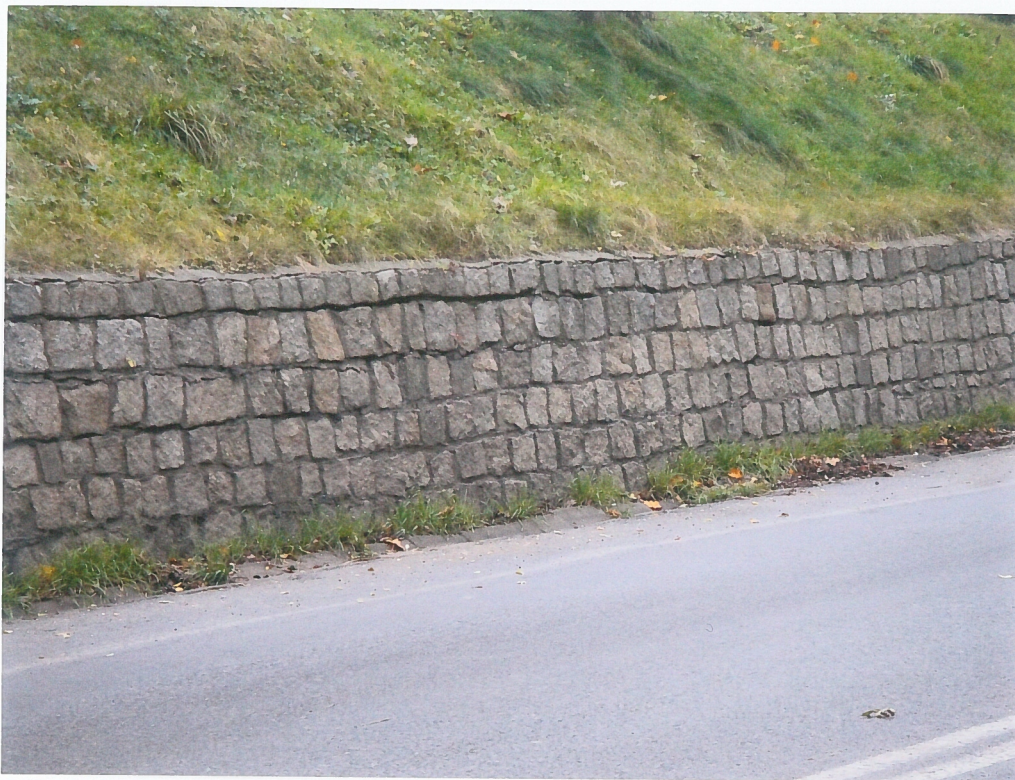
fot.45. Mur oporowy – w części środkowej. Widoczne szczeliny poziome między górnymi warstwami muru.
