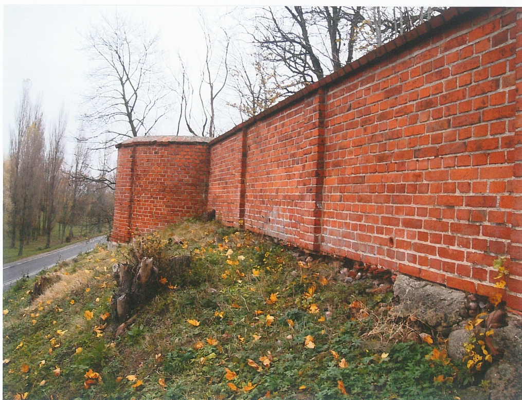
fot.28. Mur zachodni – część północna, w widoku od strony ulicy. W głębi widoczny taras widokowy. Mur jest bez zniszczeń. W części fundamentowej muru cegły są częściowo zniszczone.
