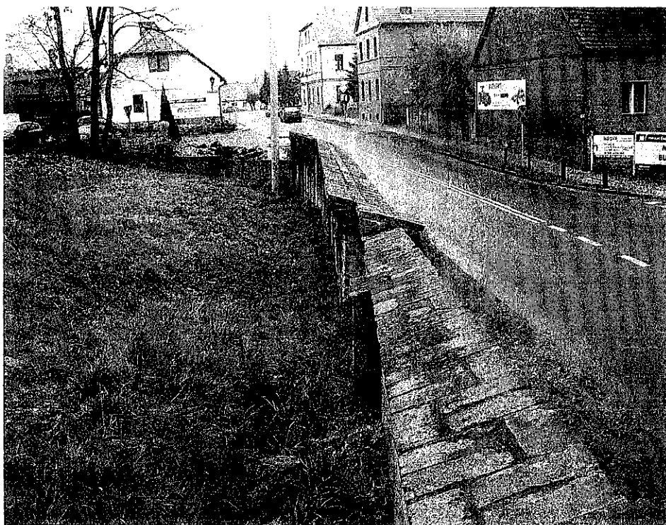
fot.12. Mur zachodni – część południowa. Korony muru są zachowane bez zniszczeń, w części spoin ubytki zaprawy.
