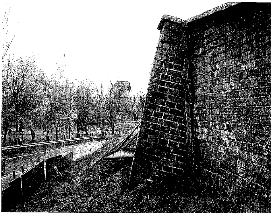
fol.16. Mur zachodni – część południowa, w widoku od strony ulicy. Widoczna przypora odspojona od muru na znaczną odległość. Przypora osiada obracając się w kierunku skarpy. Osiadanie postępuje nadal, na co wskazuje współczesne wypełnienie pęknięcia obecnie już niewystarczającej szerokości.
