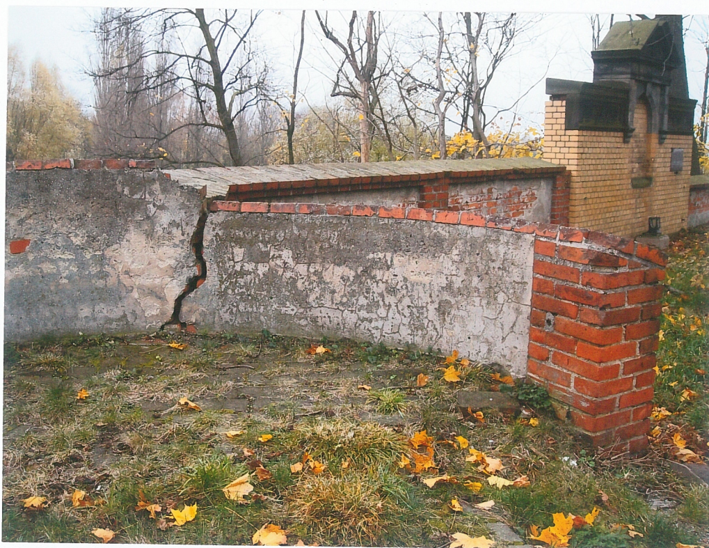
fot.34. Mur zachodni – część północna - taras widokowy. Widoczne pionowe pęknięcie muru o znacznej rozwarłości.
