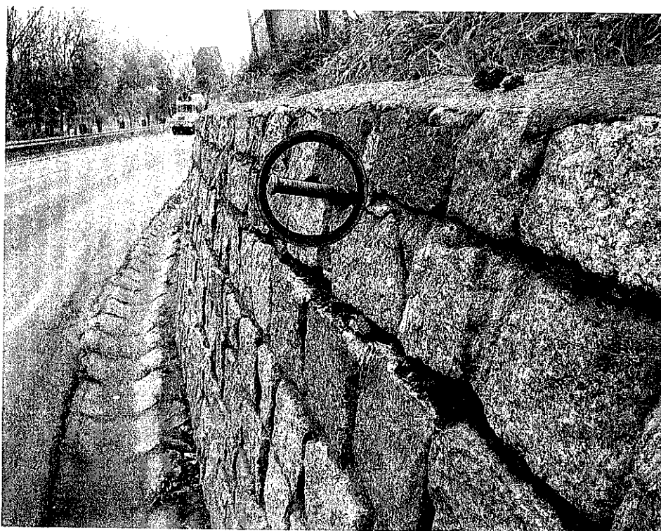
fot.47. Mur oporowy – w części północnej. Widoczne szerokie i głębokie szczeliny poziome między górnymi warstwami muru. O rozwarciu szczelin świadczy, że nóż o długości ostrza 18 cm, wchodzi w szczelinę na całą długość ostrza, mimo silnej zaprawy, którą nóż nie jest w stanie przebić. Szczeliny powstały w wyniku naporu gruntu skarpy i są świadectwem niszczenia muru, w wyniku przeciążenia.
