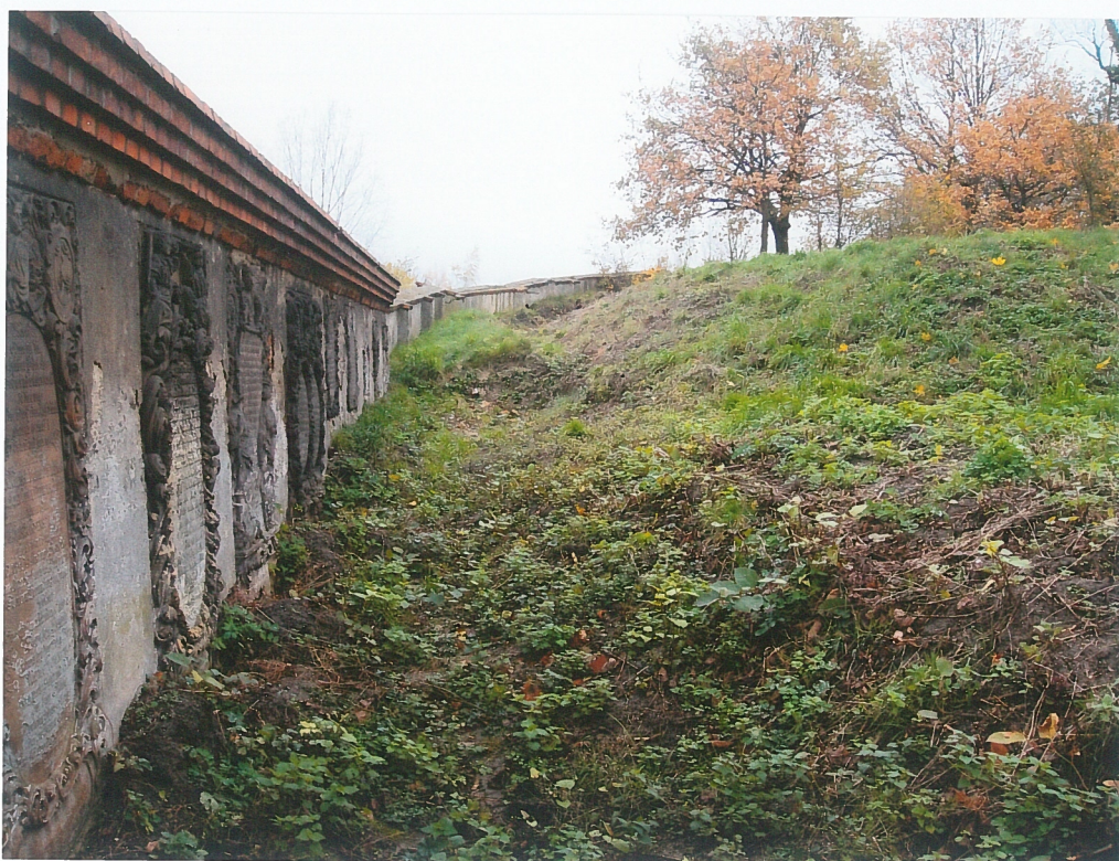
fot.9. Mur zachodni – część południowa, w widoku od strony cmentarza. Na murze płyty nagrobne. Wzdłuż muru widoczna rynna wykopana w ziemi, mająca zmniejszyć napór gruntu na mur oraz odprowadzić wodę powierzchniową, aby nie spływała z cmentarza na mur.
