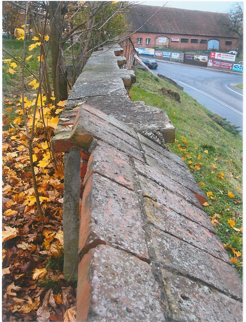
fot.29. Mur zachodni – część środkowa. Korona muru w części muru z pilastrami jest pokryta gładzią cementową, częściowo odspojoną od podłoża. Bliżej korona muru o znacznym spadku ku ulicy.
