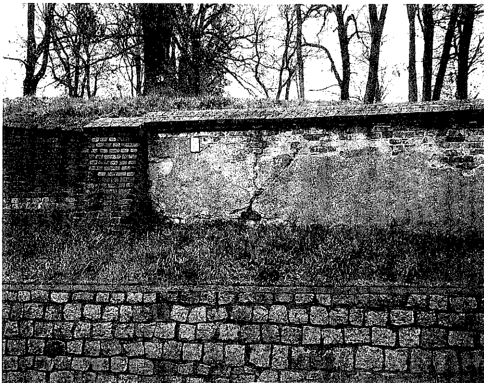
fol.15. Mur zachodni – część południowa, w widoku od strony ulicy. Widoczne ukośne pęknięcia muru przebiegające przez całą wysokość muru. Górą muru rozległe ubytki tynku.
