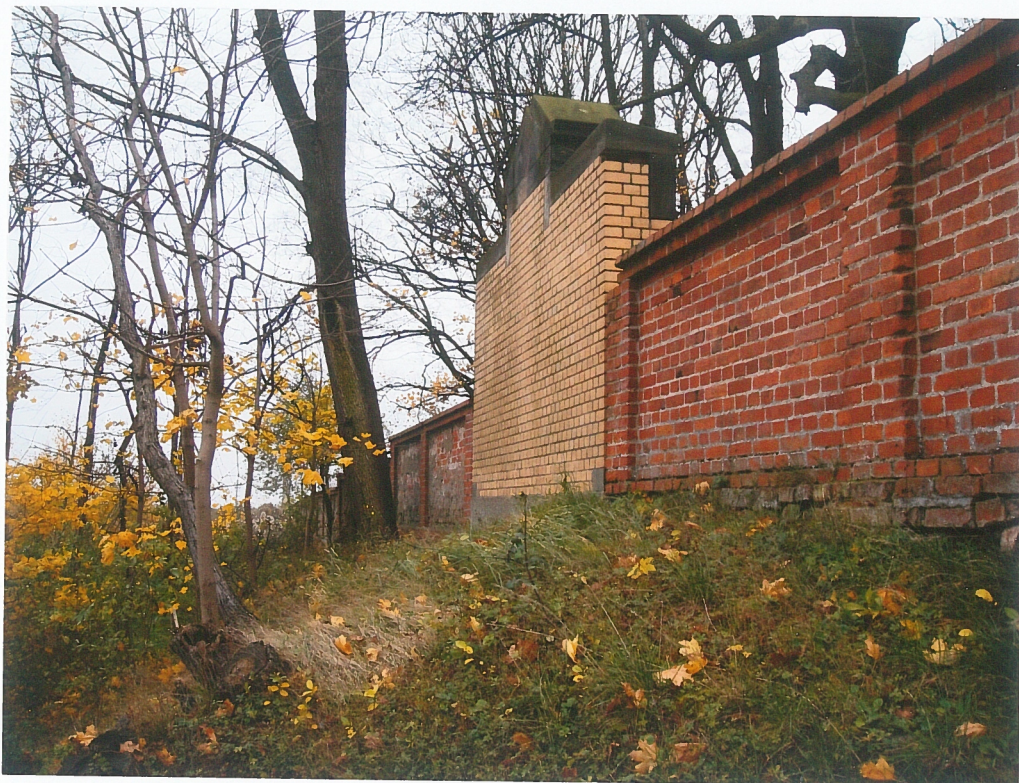
fot.35. Mur północny – część zachodnia i środkowa, w widoku od strony ulicy. Stan muru jest zadowalający, z wyjątkiem ubytków w dolnej fundamentowej partii.
