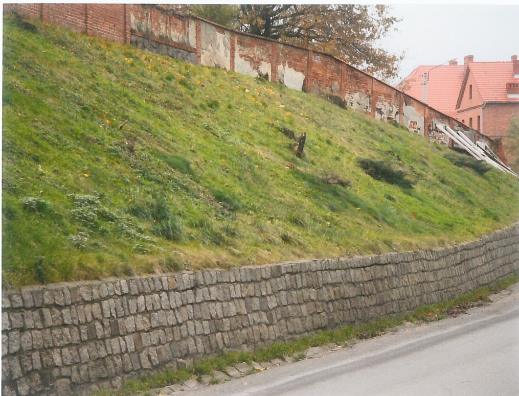
fot.39. Skarpa zachodnia w części południowej. Widoczne pnie po wyciętych drzewach. We współczesnym kamiennym murze oporowym, w jego górnej części, widoczne poziome szczeliny świadczące o odspojeniu górnych warstw muru.
