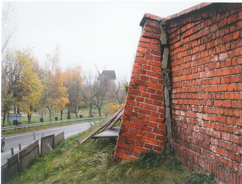
fot.16. Mur zachodni – część południowa, w widoku od strony ulicy. Widoczna przypora odspojona od muru na znaczną odległość. Przypora osiada obracając się w kierunku skarpy. Osiadanie postępuje nadal, na co wskazuje współczesne wypełnienie pęknięcia obecnie już niewystarczającej szerokości.
