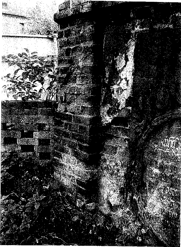
fot.13. Mur zachodni – naroże część południowo-zachodnie, w widoku od strony cmentarza. Widoczne głęboko skorodowane cegły z głębokimi ubytkami.
