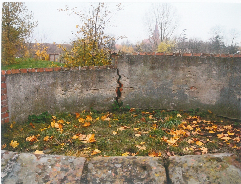
fot.33. Mur zachodni – część północna - taras widokowy. Widoczne pionowe pęknięcie muru o znacznej rozwarłości. Pęknięcie występuje w płaszczyźnie wewnętrznego lica muru zachodniego.
