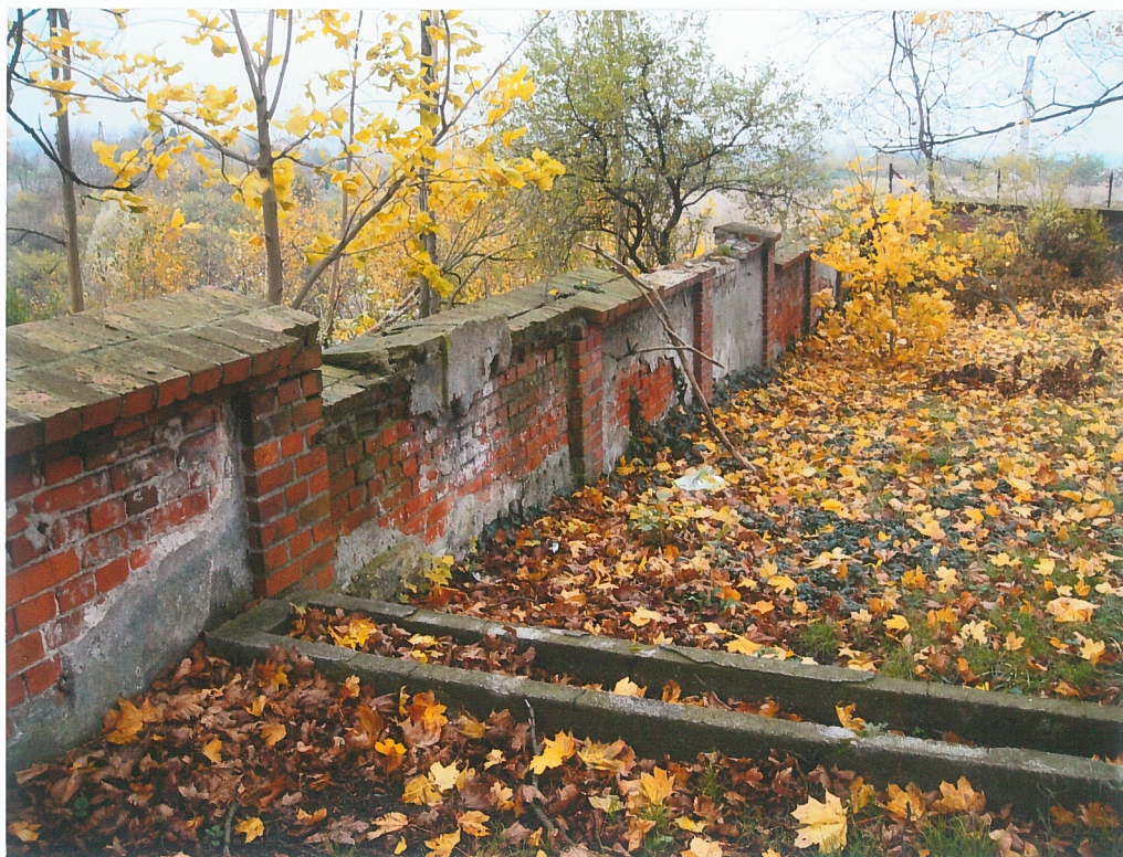
fot.8. Mur północny – część środkowa, w widoku od strony cmentarza. Widoczne rozległe ubytki tynku oraz częściowo ubytki cegieł na koronie muru.
