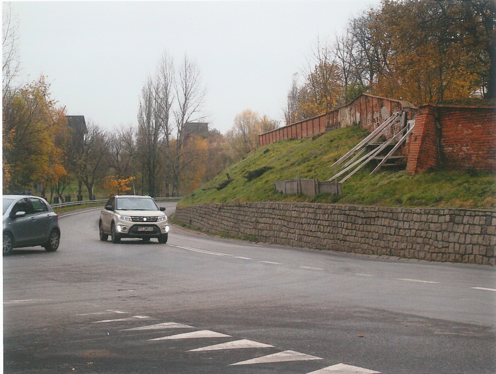
fot.3. Widok ogólny zachodniego muru cmentarnego na szczycie skarpy. Dołem skarpy, bezpośrednio przy jezdni ulicy, widoczny współczesny kamienny mur oporowy o wysokości dochodzącej do 1,50 m.
