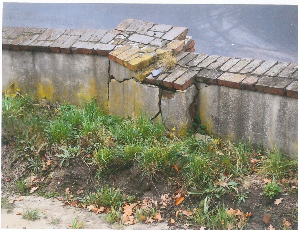
fot.22. Mur zachodni – część południowa, w widoku od strony cmentarza - część muru która uległa awarii. Widoczny pilaster muru spękany pionowo i poziomo Na koronie muru liczne ubytki zaprawy.
