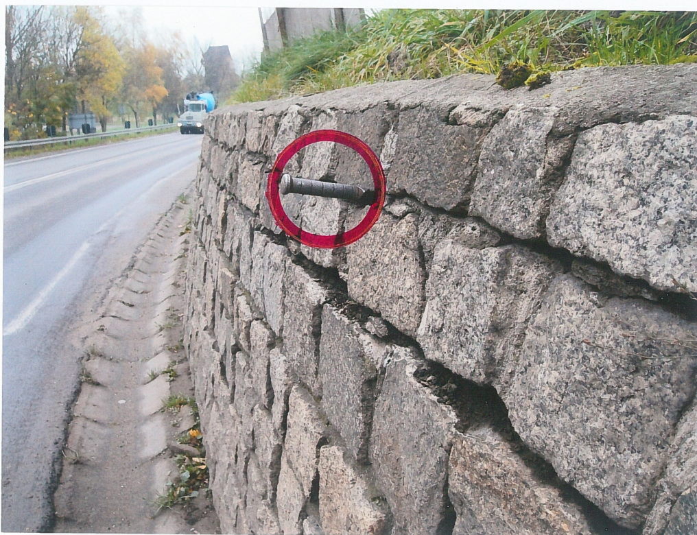
fot.47. Mur oporowy – w części północnej. Widoczne szerokie i głębokie szczeliny poziome między górnymi warstwami muru. O rozwarciu szczelin świadczy, że nóż o długości ostrza 18 cm, wchodzi w szczelinę na całą długość ostrza, mimo silnej zaprawy, którą nóż nie jest w stanie przebić. Szczeliny powstały w wyniku naporu gruntu skarpy i są świadectwem niszczenia muru, w wyniku przeciążenia.
