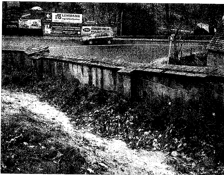
fot.21. Mur zachodni – część południowa, w widoku od strony cmentarza - część muru która uległa awarii (partia muru pokazana z przeciwnej strony na fot. 17-20). Widoczne spękania pionowe w miejscu przypory zewnętrznej oraz spękania poziome (o znacznej rozwartości) i ukośne muru. Dołem widoczny otwór na całej szerokości muru (pokazany na fot.23).
