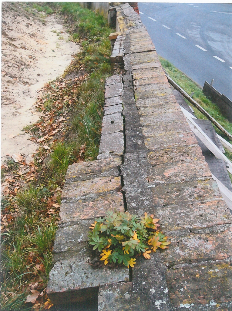
fot.24. Mur zachodni – część południowa - część muru która uległa awarii. Korona muru jest podłużnie spękana z ubytkami cegły. Po prawej stronie widoczne drewniane zastrzały prowizorycznego zabezpieczenia muru.
