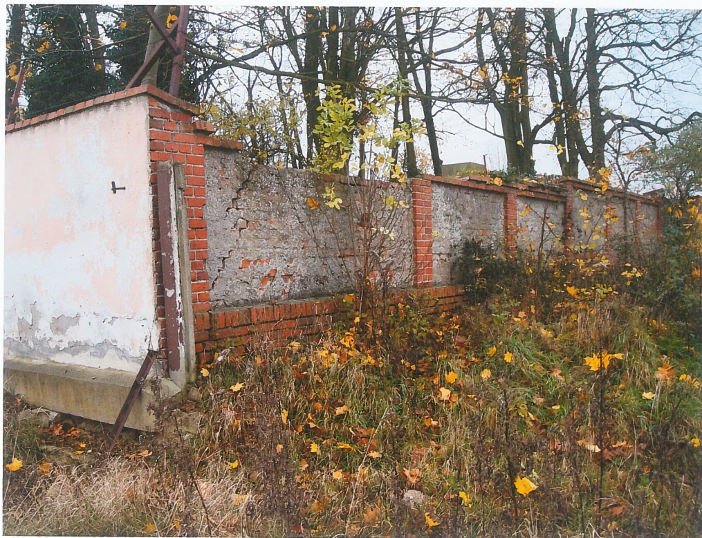
fot.37. Naroże muru północnego (po prawej) i wschodniego, nie będącego przedmiotem ekspertyzy (po lewej), w widoku od strony skarpy północnej. Mur północny jest wzmocniony pilastrami. Na koronie muru jest rozległy ubytek cegły. W pobliżu naroża muru jest ukośne pęknięcie na całej wysokości muru.
