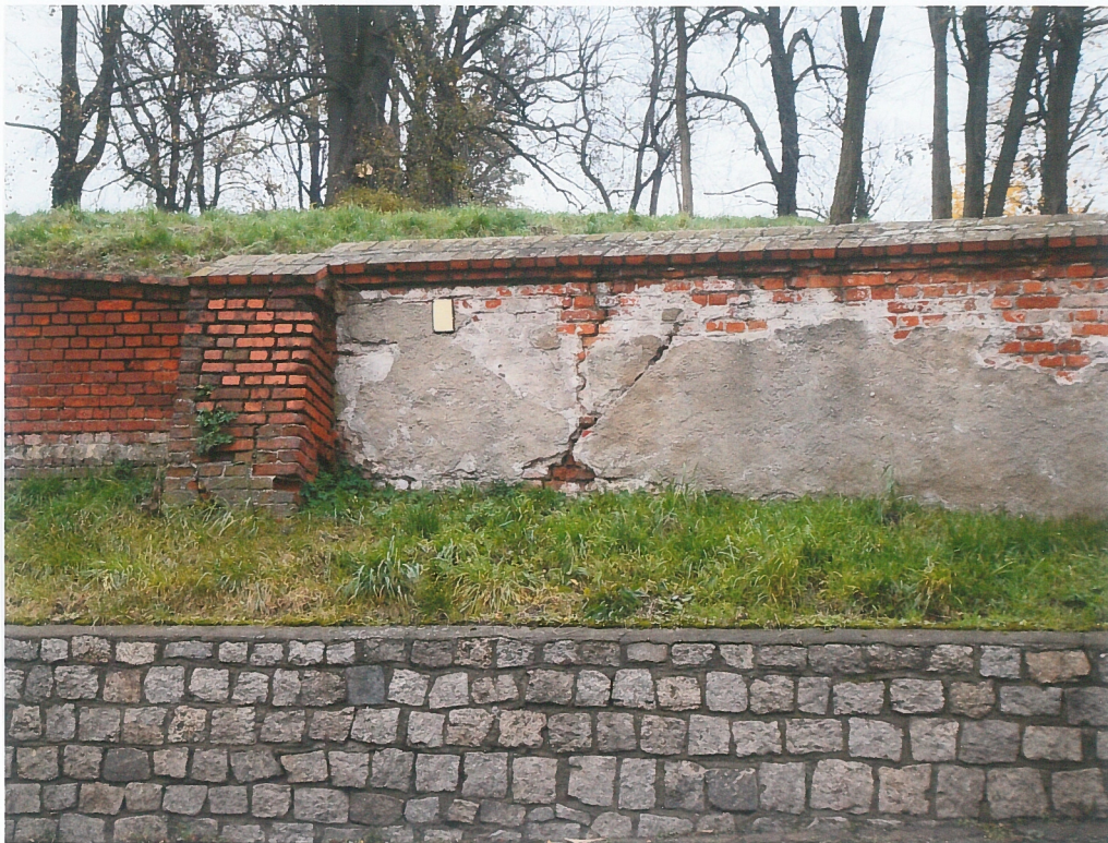
fot.15. Mur zachodni – część południowa, w widoku od strony ulicy. Widoczne ukośne pęknięcia muru przebiegające przez całą wysokość muru. Górą muru rozległe ubytki tynku.
