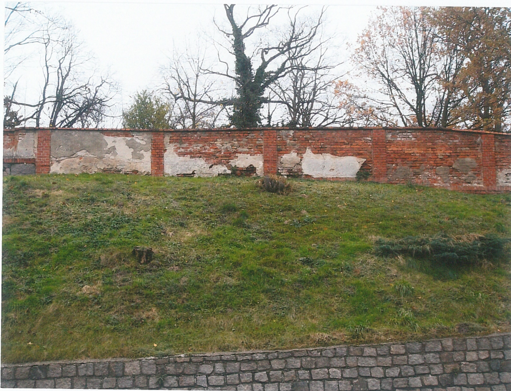
fot.25. Mur zachodni – część środkowa, w widoku od strony ulicy. Widoczne rozległe ubytki tynku oraz liczne głębokie ubytki zaprawy. Dołem skarpy widoczny współczesny kamienny mur oporowy.
