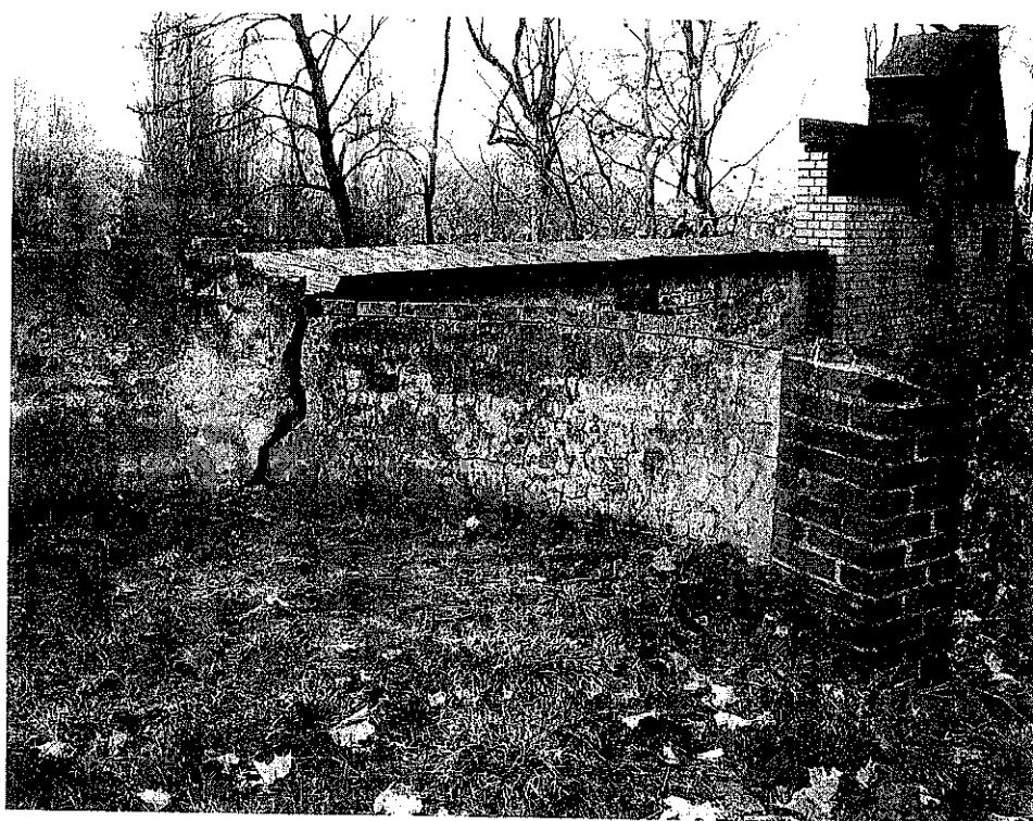
fol.34. Mur zachodni – część północna - taras widokowy. Widoczne pionowe pęknięcie muru o znacznej rozwarłości.
