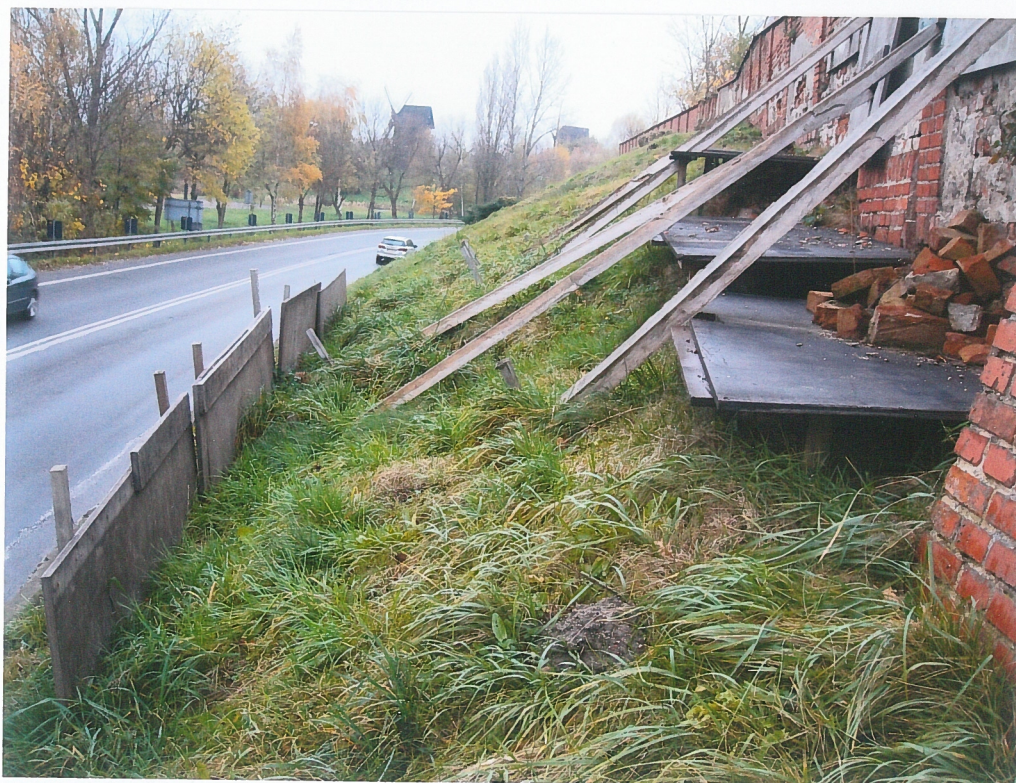
fot.18. Mur zachodni – część południowa, w widoku od strony ulicy - część muru która uległa awarii. Widoczne prowizoryczne zabezpieczenie zniszczonego muru zastrzałami drewnianymi o przekroju 16/8 cm, dołem zapartymi o kołki drewniane wbite w grunt. Po lewej stronie prowizoryczne zabezpieczenie jezdni płytami drewnianymi przed możliwością staczania się cegieł po skarpie.
