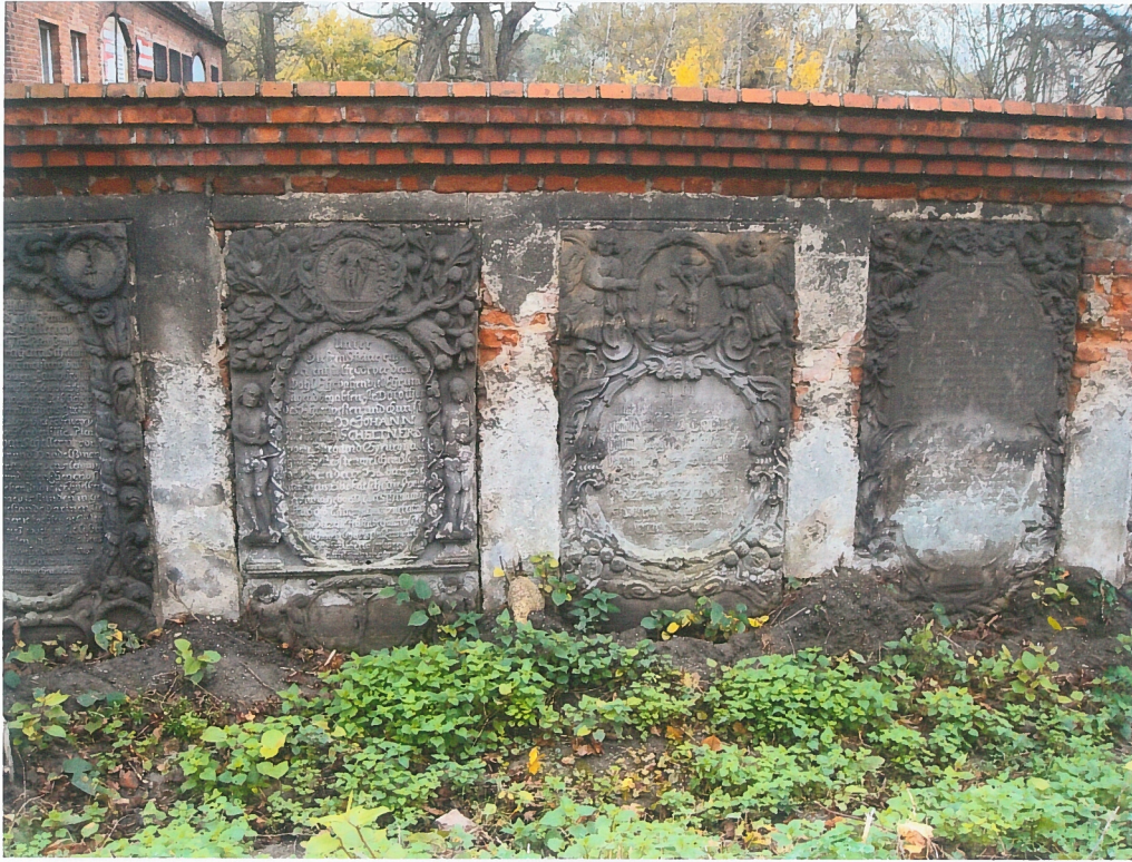
fot.11. Mur zachodni – fragment części południowej, w widoku od strony cmentarza. Widoczne płyty nagrobne wmurowane między filarkami muru. W filarkach widoczne głęboko skorodowane cegły.
