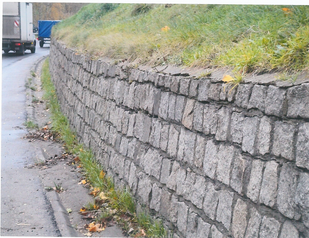
fot.46. Mur oporowy – w części północnej. Widoczne szczeliny poziome między górnymi warstwami muru.
