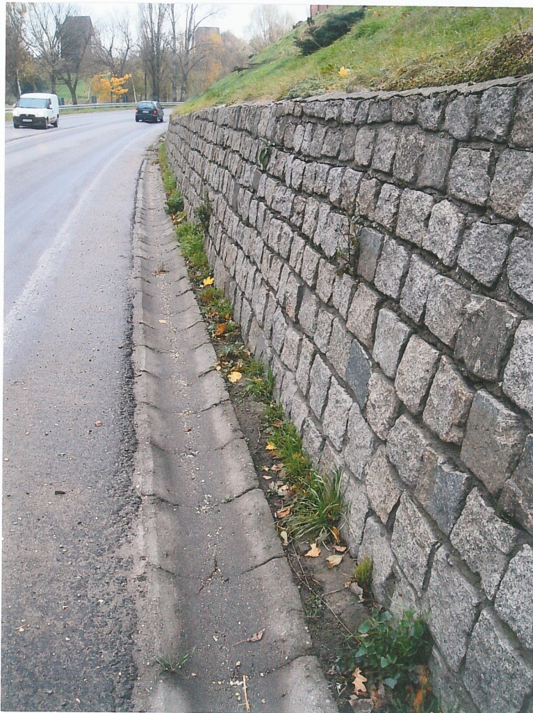
fot.44. Mur oporowy - w części środkowej. Mur został wykonany współcześnie z kostki kamiennej granitowej, o wymiarach około 20/20, 30/20 cm, na mocnej zaprawie cementowej. Między murem oporowym, a jezdnią ulicy jest koryto z elementów betonowych odprowadzające wodę opadową.
