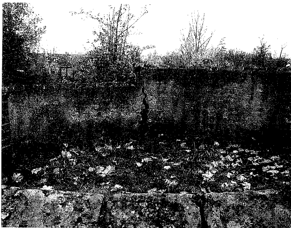
fol.33. Mur zachodni – część północna - taras widokowy. Widoczne pionowe pęknięcie muru o znacznej rozwarłości. Pęknięcie występuje w płaszczyźnie wewnętrznego lica muru zachodniego.
