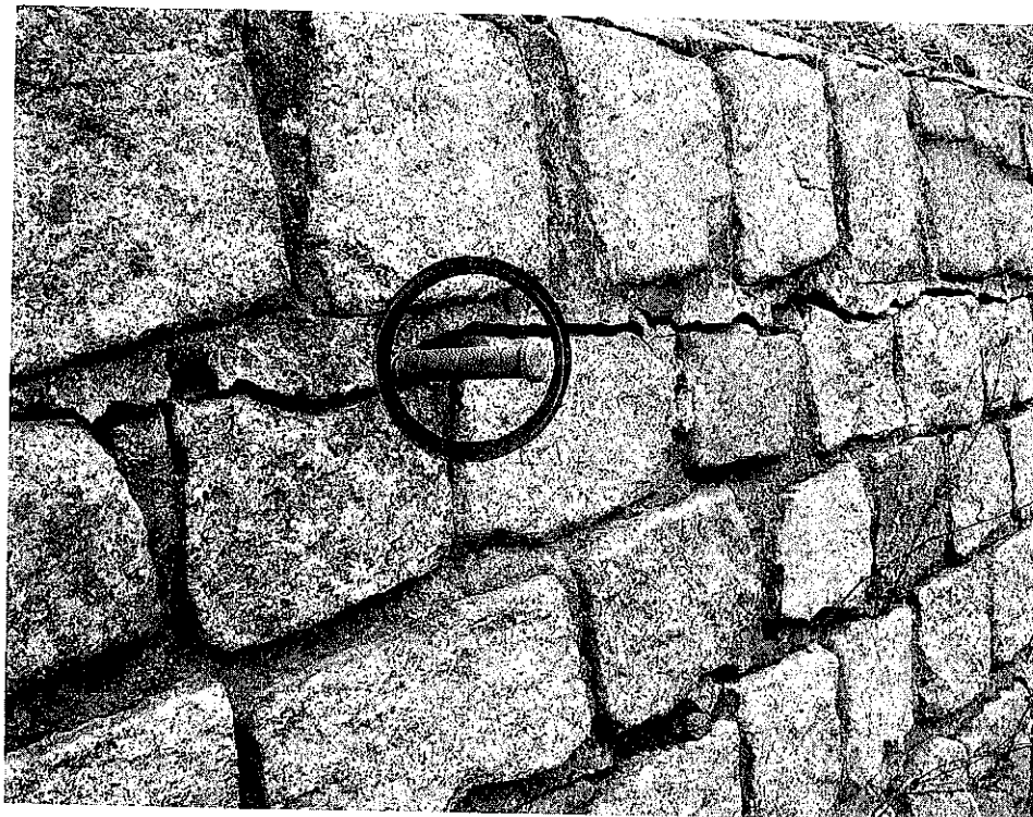
fot.48. Mur oporowy – w części środkowej. Widoczna szeroka szczelina, która powstała w spoinie pod górną warstwą kamienną muru. W spoinach w niższych warstwach również są poziome szczeliny. Na zdjęciu widoczny jest nóż włożony do górnej szczeliny. Szczeliny powstały w wyniku naporu gruntu skarpy i są świadectwem niszczenia muru, w wyniku przeciążenia.
