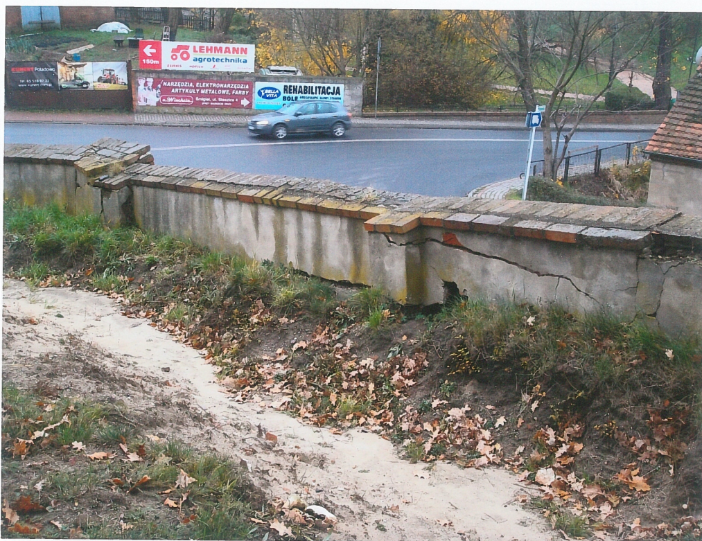
fot.21. Mur zachodni – część południowa, w widoku od strony cmentarza - część muru która uległa awarii (partia muru pokazana z przeciwnej strony na fot.17-20). Widoczne spękania pionowe w miejscu przypory zewnętrznej oraz spękania poziome (o znacznej rozwartosci) i ukośne muru. Dołem widoczny otwór na całą szerokości muru (pokazany na fot.23).
