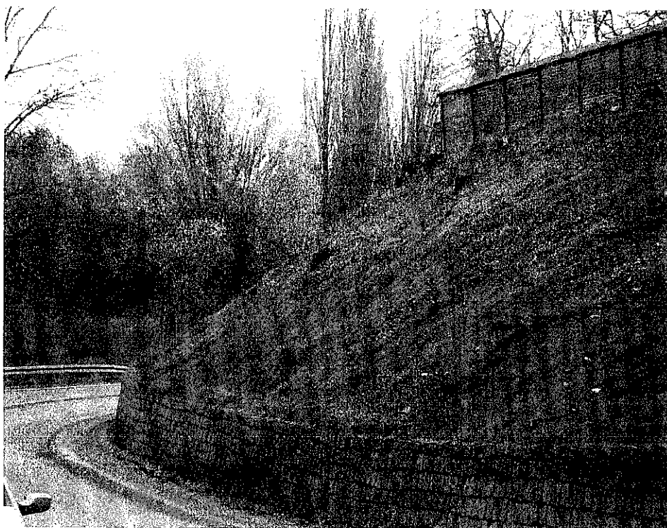
fot.40. Skarpa zachodnia w części środkowej. Widoczne pnie po wyciętych drzewach. We współczesnym kamiennym murze oporowym, w jego górnej części, widoczne poziome szczeliny świadczące o odspojeniu górnych warstw muru.
