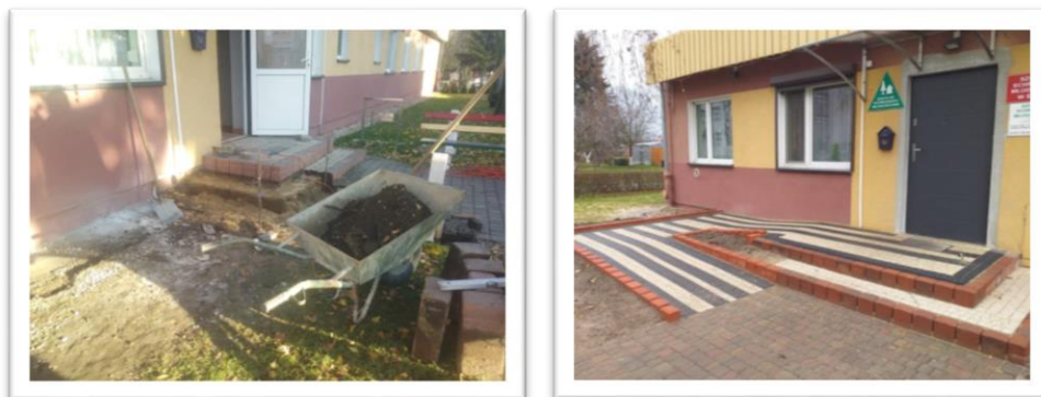
Zdjęcie 4 Przebudowa wejścia do budynku Szkolnego Schroniska Młodzieżowego
