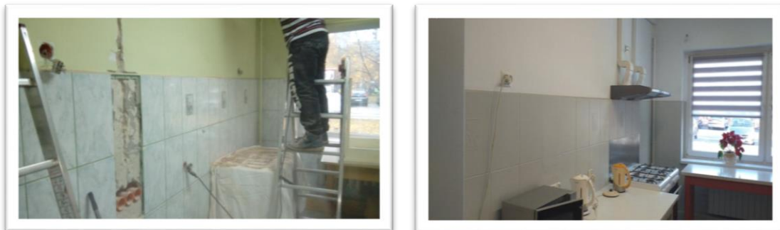
Zdjęcie 3 Remont kuchni w Szkolnym Schronisku Młodzieżowym
